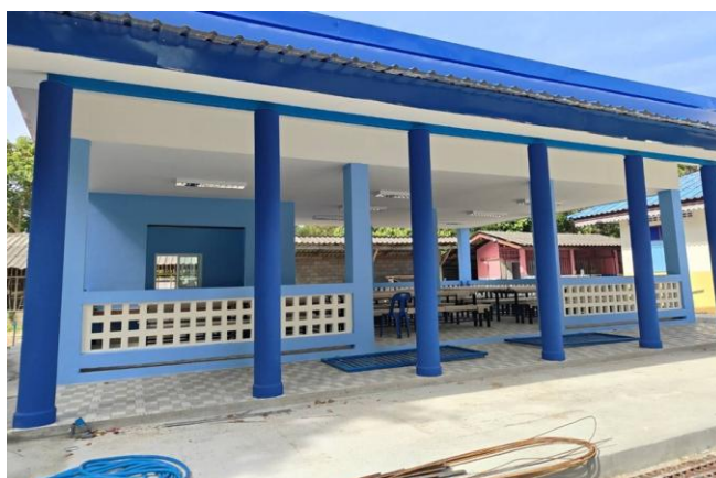
โรงเรียนวัดโคกโพธิ์สถิตย์ ได้รับงบประมาณก่อสร้างอาคารโรงอาหาร 84 ที่นั่ง งบประมาณ 1,171,300 บาท
